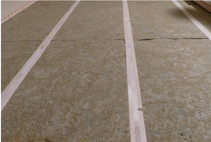
Bild 1: Rahmenkonstruktion mit Bedämpfung
